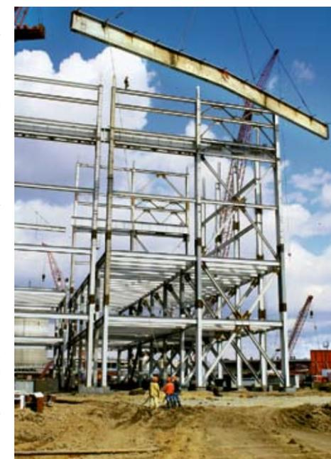
На стройплощадке Троицкой ГРЭС кипит работа — произведен монтаж первой балки перекрытия турбинного отделения нового энергоблока.
